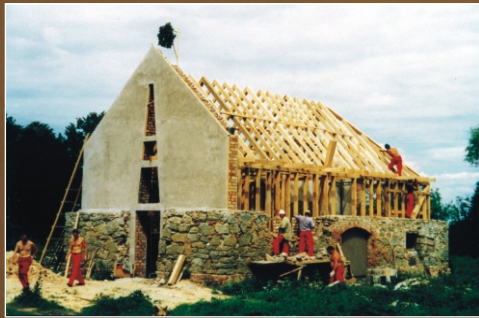
Die Kapelle im Rohbau
